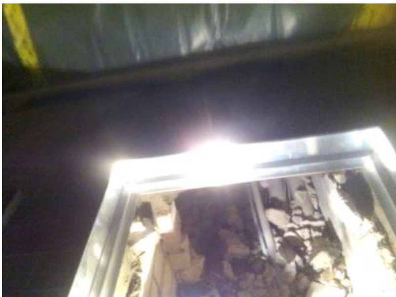
5. Februar abends: Die ersten Fliesen im Kirchenschiff sind verlegt, auch der Rahmen für den Revisionschacht zum Luftkanal ist schon eingebaut.
