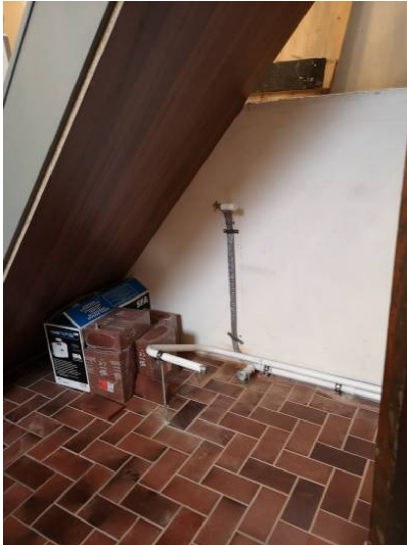
Mitte Februar: WC im Rohbau.
